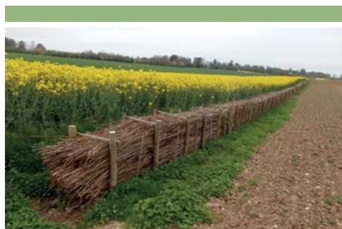
Fascine au moment de sa création – printemps 2010 (BV Quiberville-Longueil – Terrefaune) © SBVSVS
